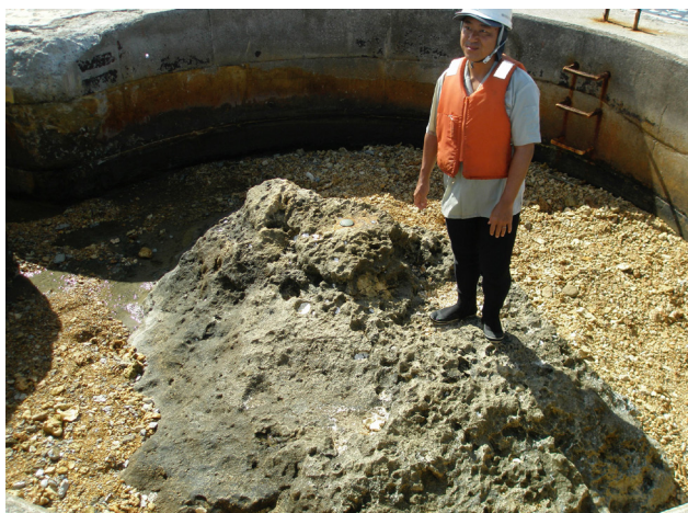
図5 東小島。現在は、チタン製の防護工が設置されている。
