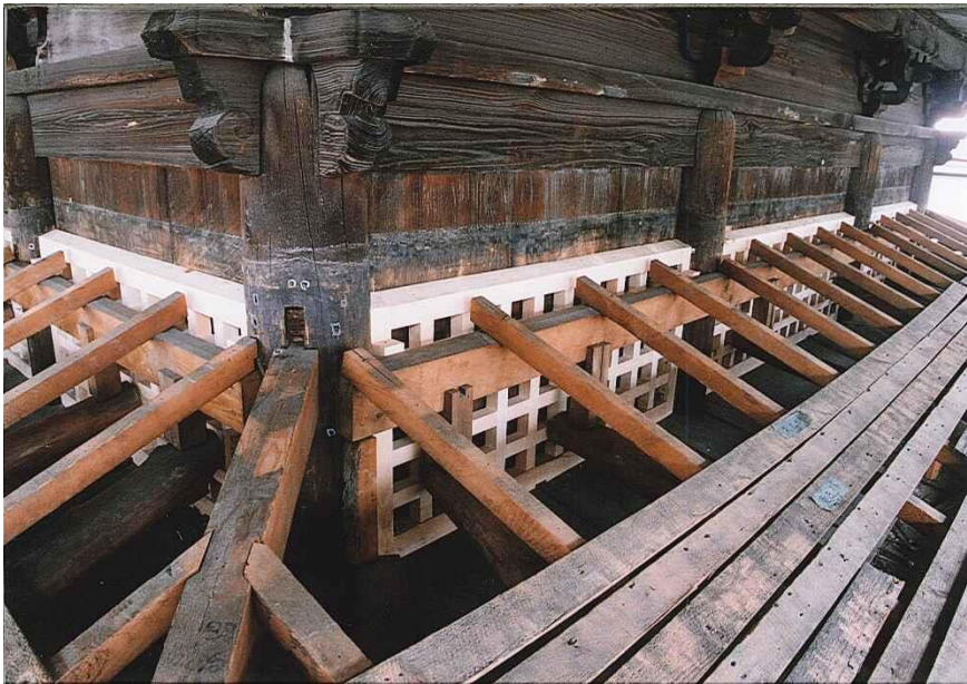
仏堂の耐震補強（屋根で隠れる箇所にも格子壁を設置）
